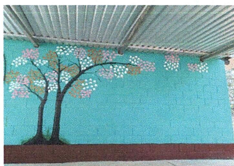
Foto 2: terminado de encubierta de lamina en las aulas especificadas
