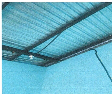
Foto 4: sistema eléctrico terminado en su totalidad
